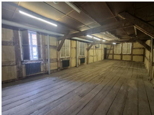
Hofgebäude als Bereich für die zukünftige Dauerausstellung
